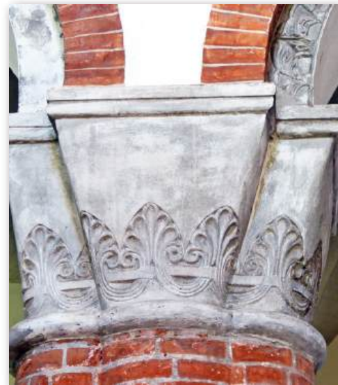
Detailaufnahme romanisches Kapitell Mittelschiff
