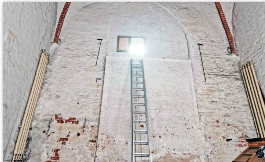
Mit Errichtung der Orgelempore im 20. Jh. wurde das Fenster der Westfassade auf der Innenseite der Laibung mit Mauerwerk geschlossen und eine Holzluke für Revisionszwecke vorgesehen.
