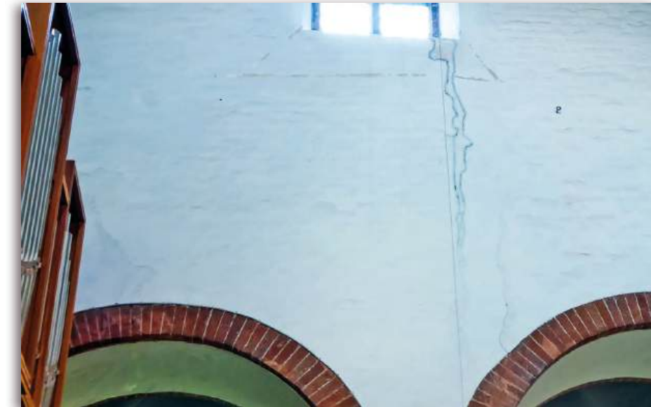
Breiter Riss Schildwand Mittelschiff
